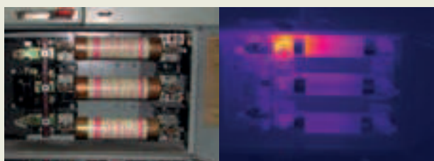
Odłączony bezpiecznik
