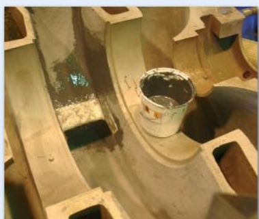
Pic. 3: Nanoszenie powłoki Loctite® 7227 na korpus (posiada certyfikat dopuszczający do kontaktu z wodą do picia)
